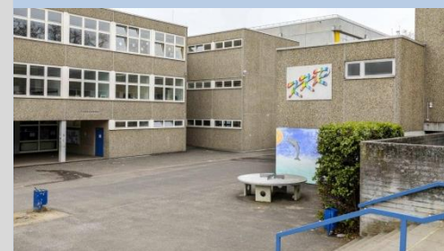
Oben: Ist-Zustand Realschule KKR, Gonsenheim
